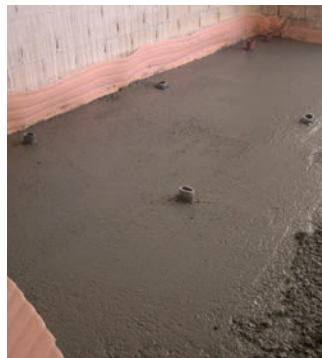
Colocación del mallazo y hormigonado.
