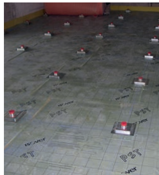
Acondicionamiento del local e instalación de los soportes.
