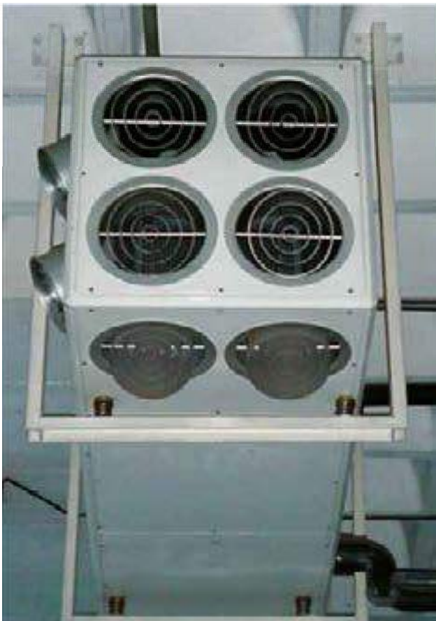
Sistema de ventilación aislada con VIBRABSORBER®
