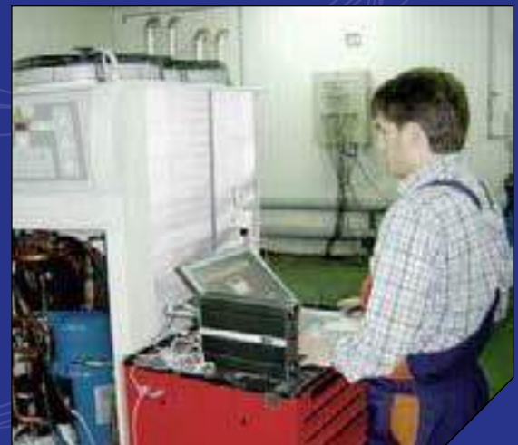
Medición de vibraciones
