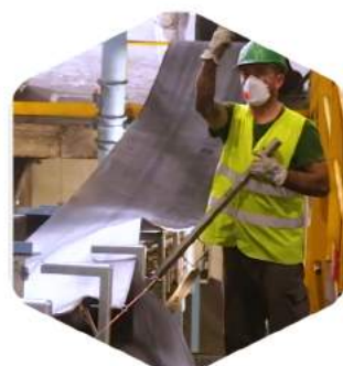
Empalmes/colagens no local; Encurtamento, prolongamento de transportadores; Serviço 24H
