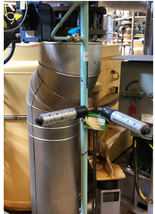
Devido à elevada contrapressão, cada um dos copos foi também equipado com um impulsor de pressão IMPULSE.
