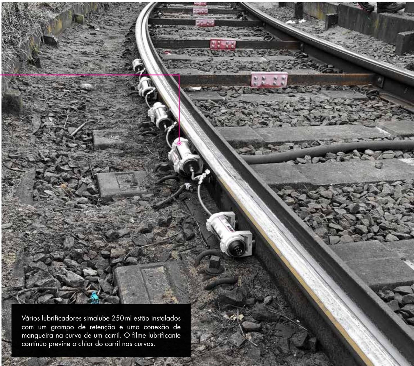
Vários lubrificadores simalube 250 ml estão instalados com um grampo de retenção e uma conexão de mangueira na curva de um carril. O filme lubrificante contínuo previne o chiar do carril nas curvas.
