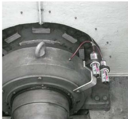
Dois lubrificadores 250 ml simalube lubrificam o rolamento principal de uma eólica.
