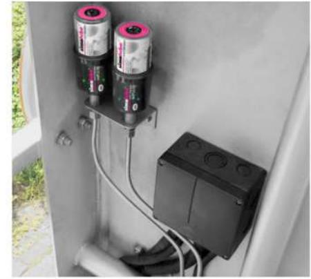
Devido às linhas de lubrificação permanentemente instaladas na limpeza de uma piscina, são usados dois simalube IMPULSE connect. Eles superam a contrapressão e garantem lubrificação contínua.
